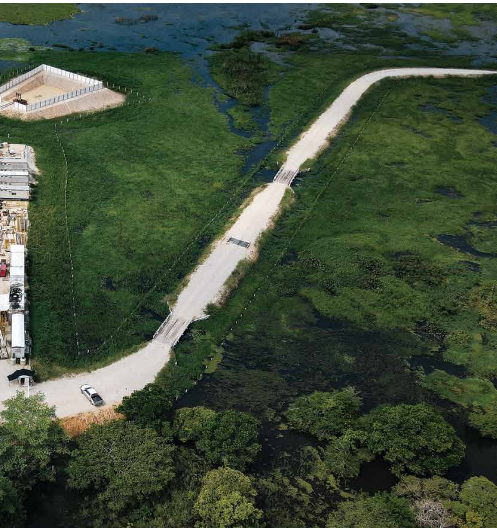
Urhani : Construcción de camino de acceso y localización Urhani. Localización : Minatitlán, Veracruz. Cliente Final : Halliburton.
