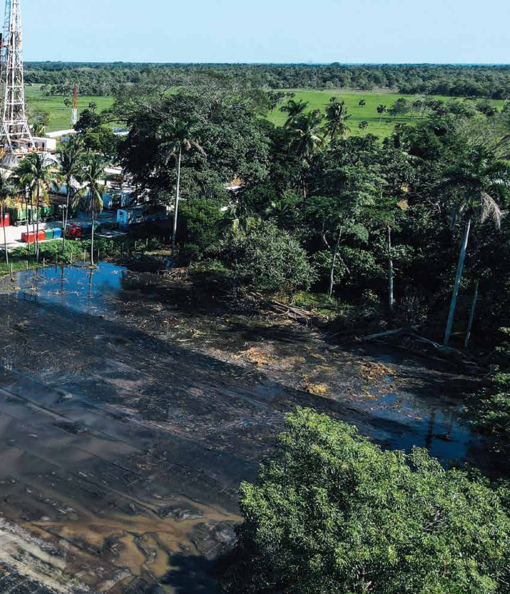
Tupilco 1 DL : Construcción de camino de acceso, pera y presa de quema para la localización exploratoria Tupilco 1 DL. Localización : Comalcalco, Tabasco. Cliente Final: PEMEX.
