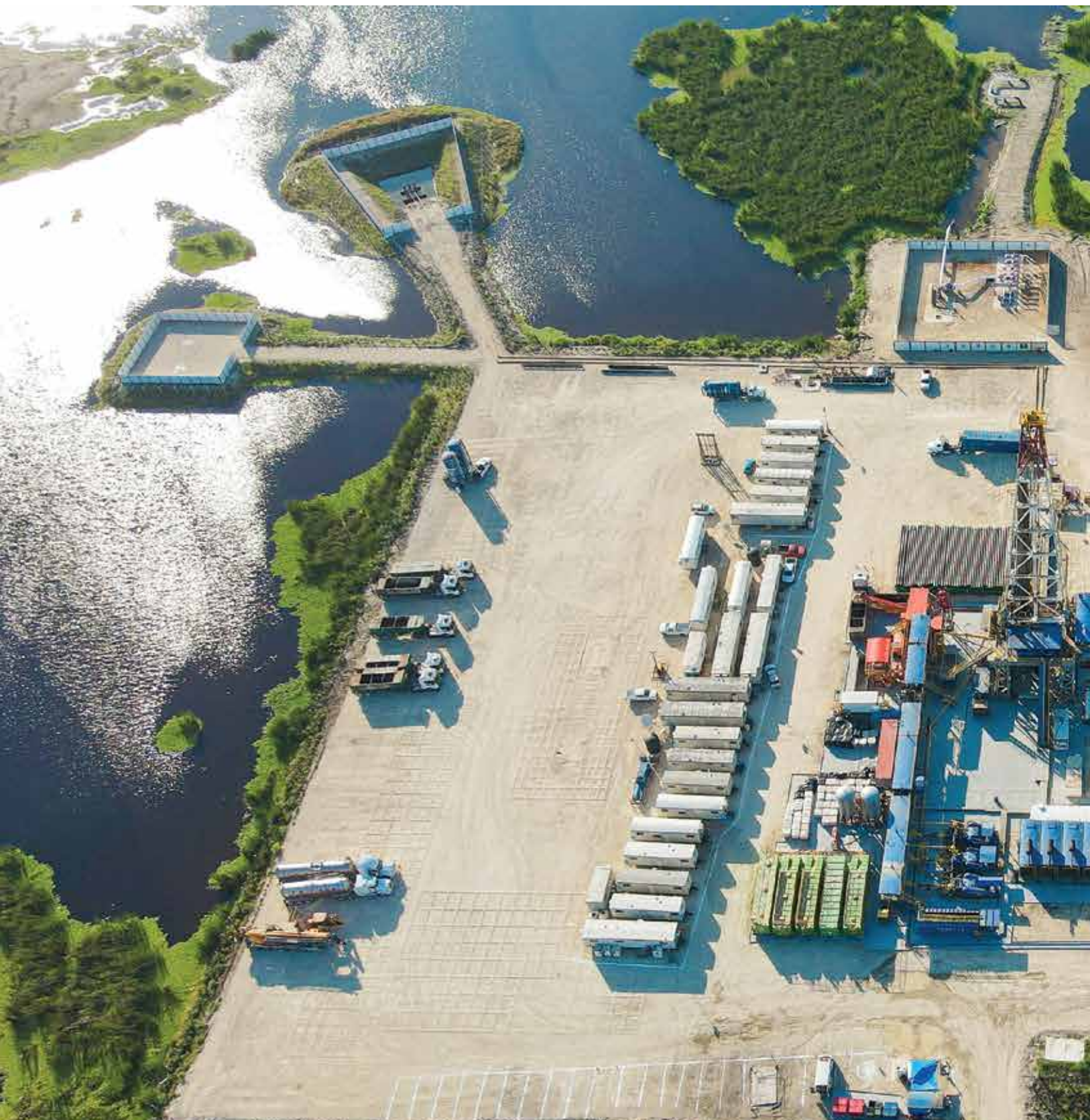
Tupilco 84 : Construcción de camino de acceso, pera y presa de quema para la localización exploratoria Tupilco 84. Localización : Comalcalco, Tabasco. Cliente Final: PEMEX.
