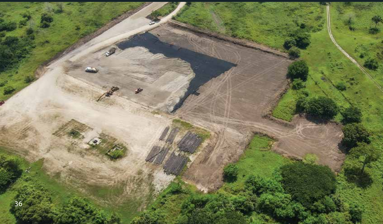
Tupilco 153 : Construcción de camino de acceso, pera y persa de quema para la localización exploratoria Tupilco 153. Localización: Comalcalco, Tabasco. Cliente Final: PEMEX.
