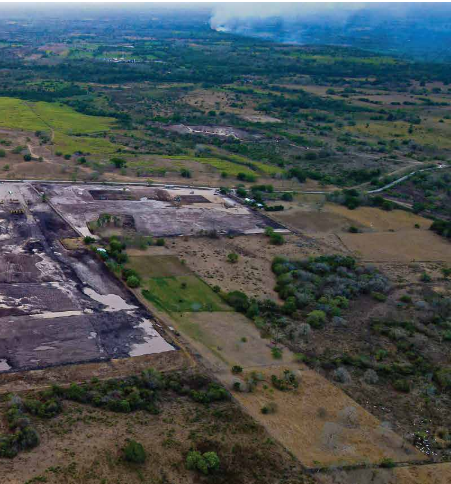
Bateria Ixachi : Acondicionamiento de terreno para la batería Ixachi , (ZONA A). Localización : Tierra blanca, Veracruz. Cliente Final : PEMEX.
